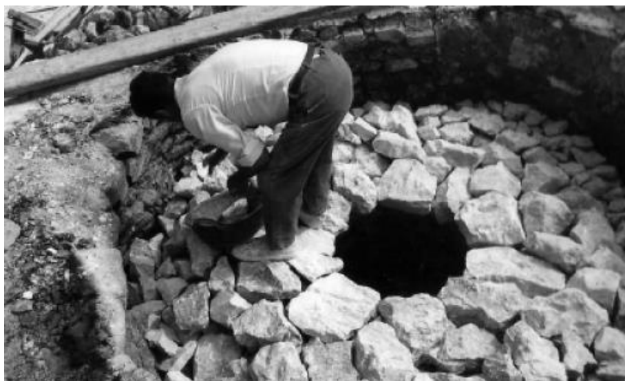
Fig.1. Uno de los últimos caleros de Vinaròs colocando las últimas piedras de la bóveda de un horno de cal. Baila Lletí et al (2012, pag. 42).
