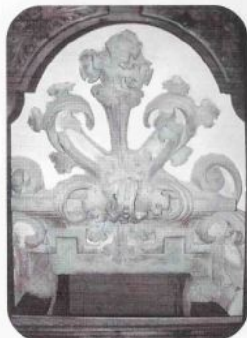
Decoració amb algepseries de la finestra oculta darrere de l'àtic de l'orgue. Es tracta de l'únic exemplar conservat de la primitiva ornamentació barroca del temple.
