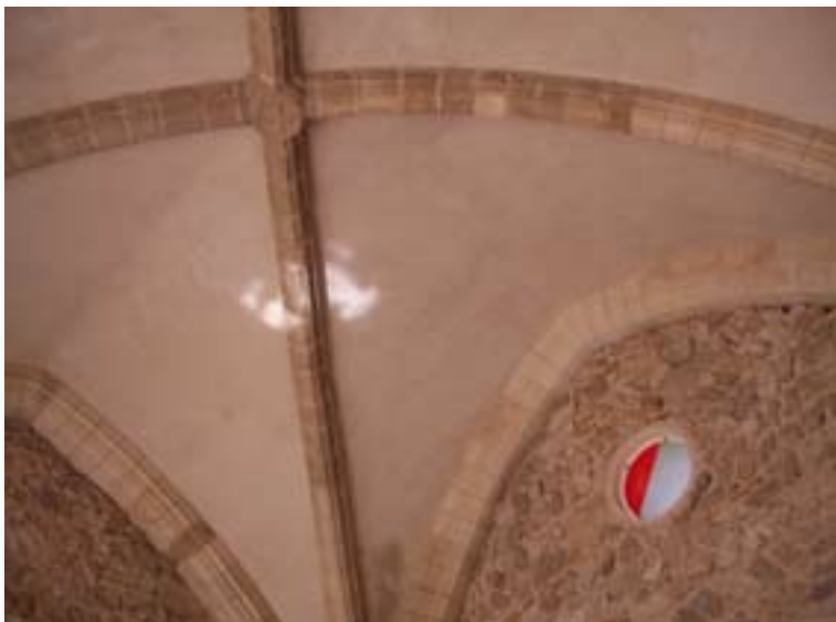
Detall de la volta de creueria
