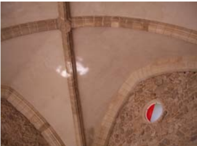
Detall de la volta de creueria
