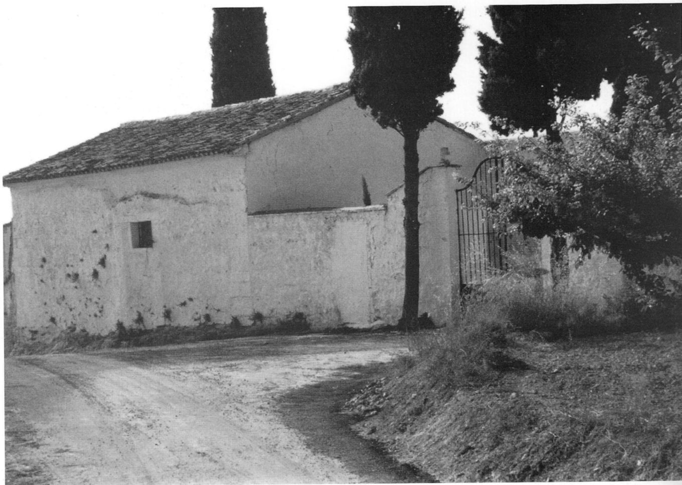
Ermita de Sant Sebastià. Vista parcial des del costat oest
