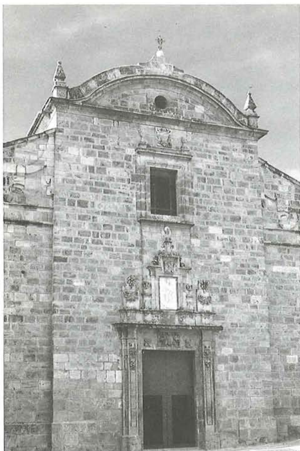
Església de l'Assumpció. Façana principal.
