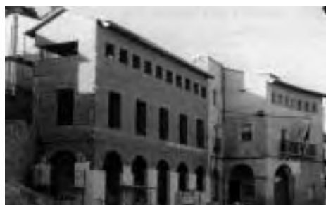
L'ampliació de l'Ajuntament després de l'enderrocament de les cases afegides als anys cinquanta
